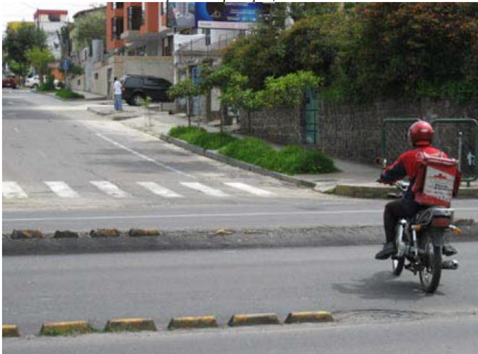
Figura 2.25 - Com maior deterioração da separação, mais veículos invadem a faixa de ônibus
