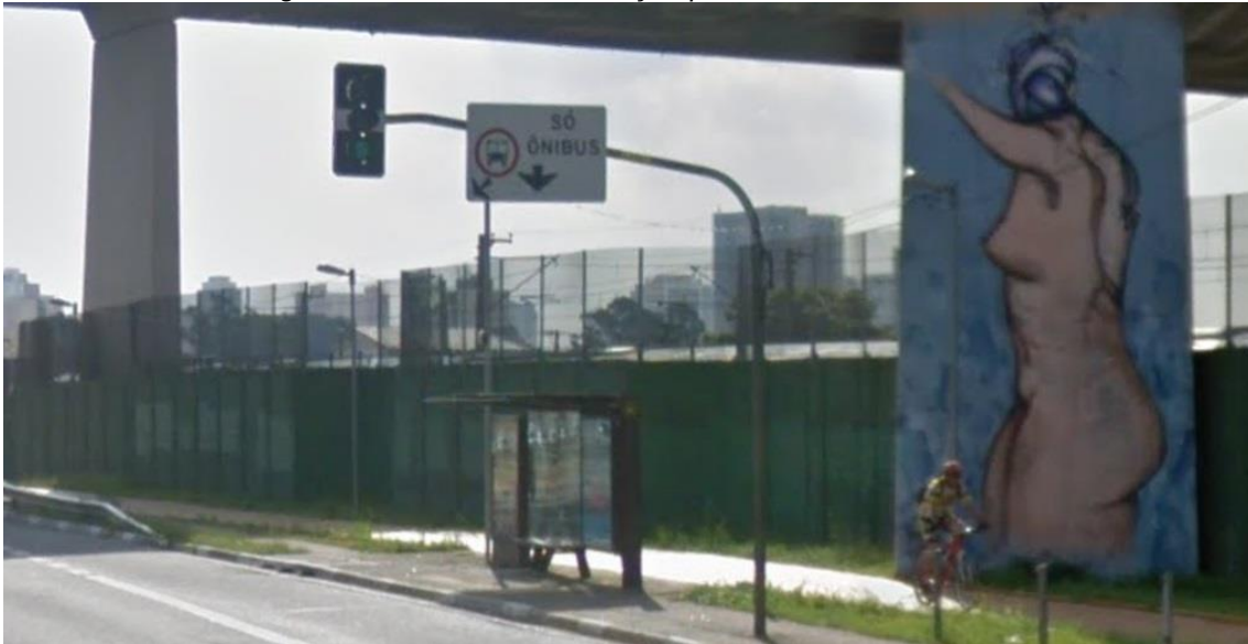
Figura 3.6 - Placa de sinalização para faixa exclusiva de ônibus
