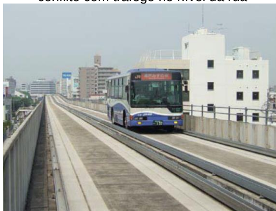
Figura 2.30 - Em Nagoya, a linha Yutorito utiliza estrutura rodoviária elevada para evitar qualquer conflito com tráfego no nível da rua
